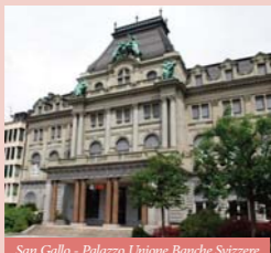
San Gallo - Palazzo Unione Banche Svizzere
